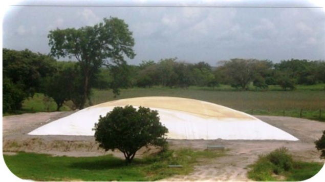
Almacenamiento de biogás
