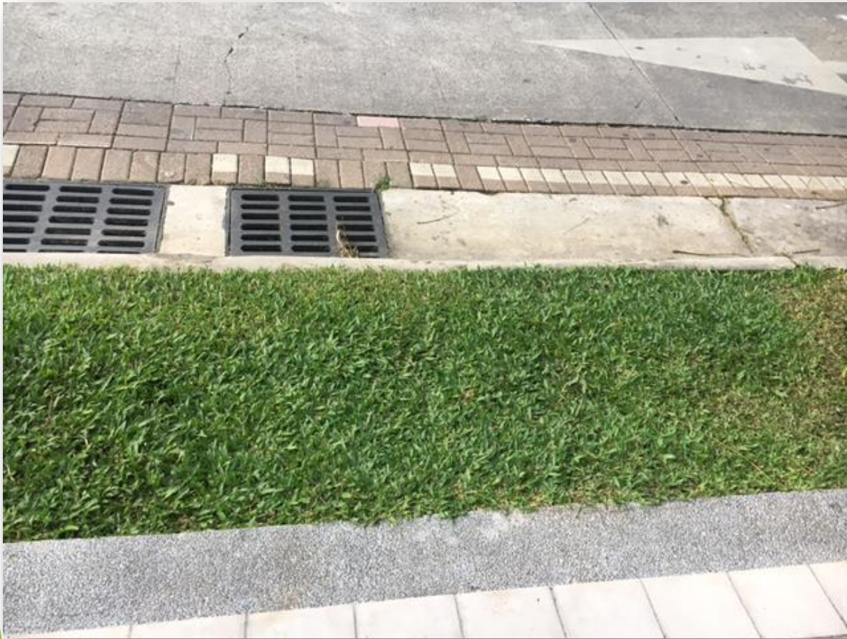
Bioretención, infiltrantes, para gestionar la excedencia
