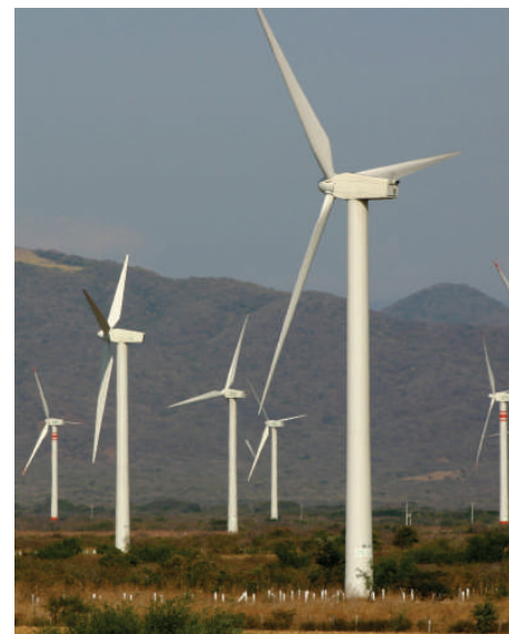
Parque eólico de generación de energía eléctrica.
