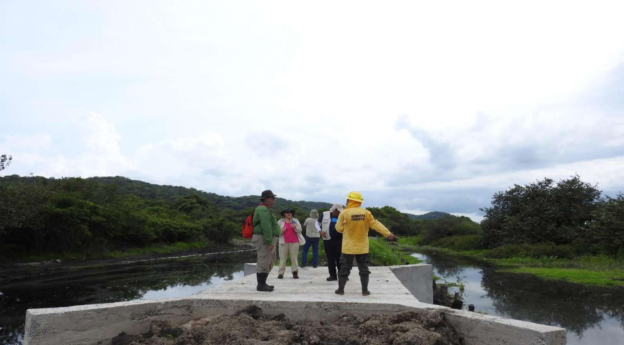
**Construcción de una represa de 2 metros de alto y 5 metros de ancho en la base, para eliminar el riesgo de inundación por rompimiento del canal de alivio del sistema de riego**
